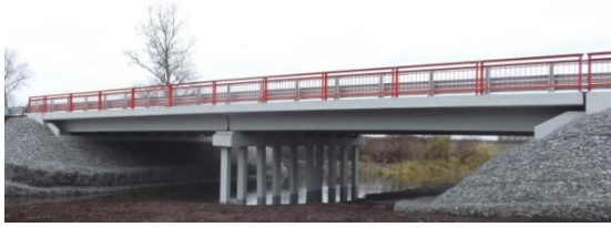
Рис.1. Общий вид двухпролётного железобетонного моста
